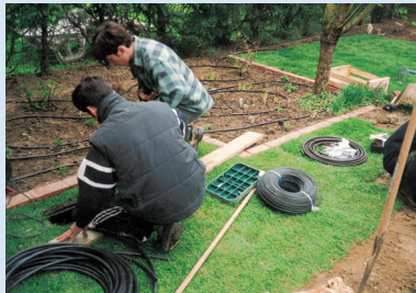
Conception et réalisation de chantiers
